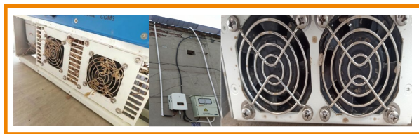
Hình 3: Vụn rác làm tắc nghẽn quạt và đường dẫn khí của biến tần, gây hỏng hóc biến tần
