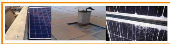
Abbildung 4: Verdeckung und Beschädigung von PV-Paneele
